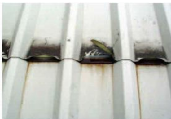
Painel com 7 anos- chapa galvanizada
