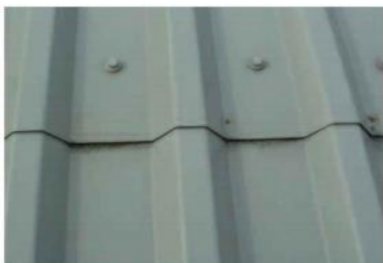
Painel com 7 anos- revestimento HPS200 Ultra® com Galvalloy®
