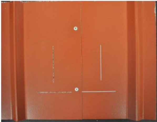
Figura 19: Teste de 24 meses de exposição de quinagens 1T e 3T contra a corrosão.
