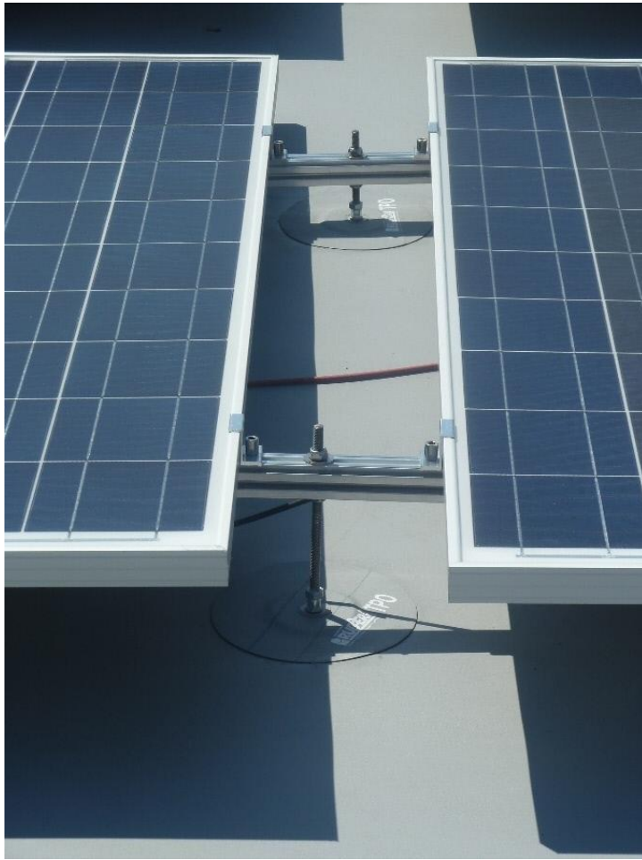
Sistema RubberFix puesto en obra
